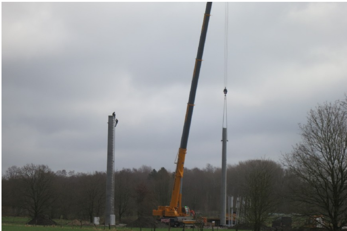
Der Kran holt das obere Segment. Auf dem unteren warten zwei Männer, um die beiden Teile zusammenzufügen (unten).
