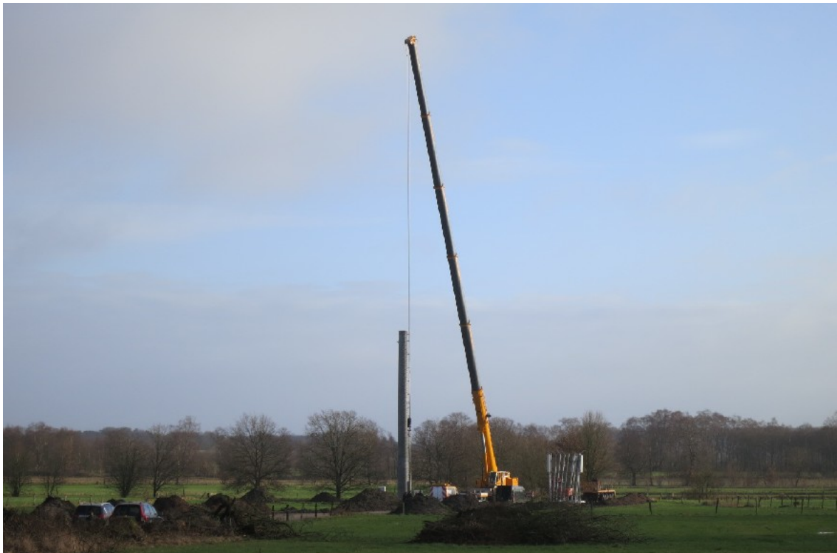
Der Kran holt das obere Segment. Auf dem unteren warten zwei Männer, um die beiden Teile zusammenzufügen (unten).
